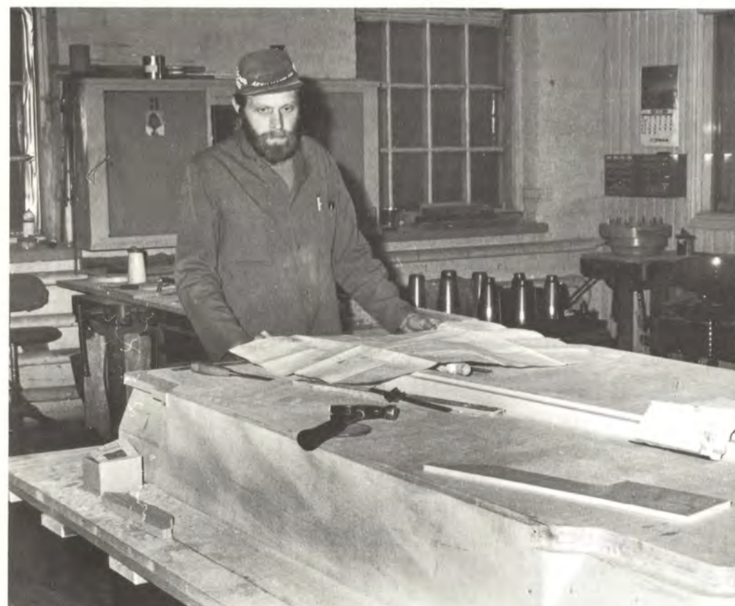
Mallipuuseppä Kari Laineelta on tällä kertaa syntymässä ison valukappaleen malli.
