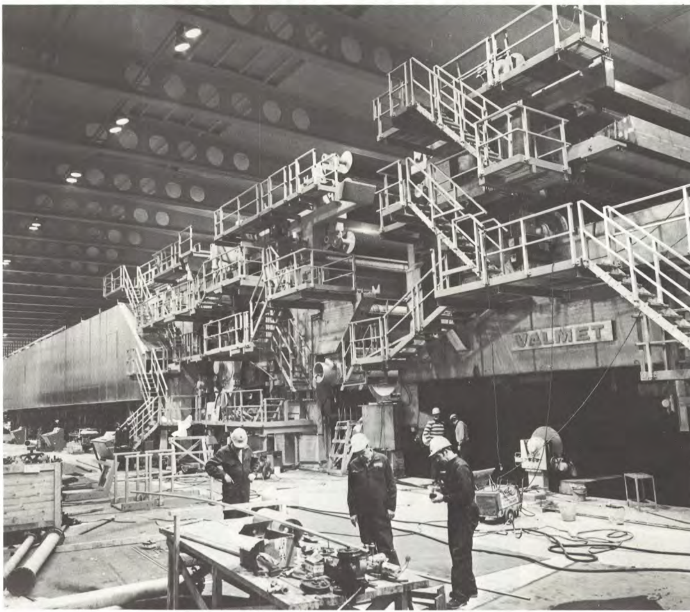
Kuusanniemen rakennettava PK 8 on viimeisten viikkojen aikana muuttanut muotoaan päivittäin. Koneella on valmistuessaan pituutta 116 metriä, etualalla näkyvän puristinosa korkeus on noin 11 metriä lattiatasosta mitattuna. Asennustyöt olivat tammikuun viimeisellä viikolla kuumimmillaan, koneen parissa hääri noin 360 asentajaa.
