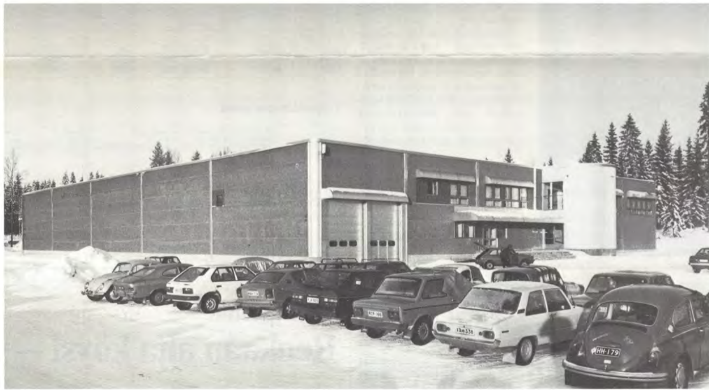
Kouvolan Kirjapainon toimitalo oli ensimmäinen Katajaharjun uudelle teollisuusalueelle noussut rakennus. Piha ehdittiin asfaloitaa syksyllä, keväällä ovat vuorossa ympäristön viimeistelyt.
