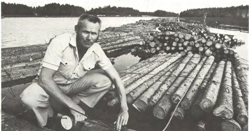
Kymin Uittoyhdistyksen piiriesimies Reijo Hohti tarkastelemassa Voikkaan padon yläpuolella tukkinippujen kuntoa.
