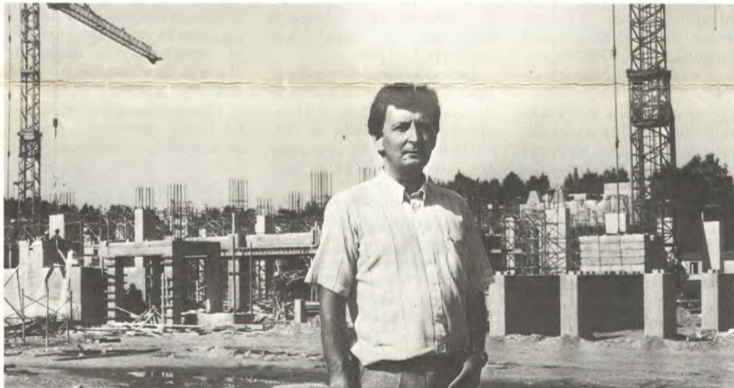
Tehdaspalvelun päällikkö Kyösti Peltonen esittelee uuden kuorimon ja hiomon rakennustöitä. Vasemmalla näkyvän perustuksen päälle asennetaan elokuun puolivälissä 51 tonnia painava kuorimarumpu.
