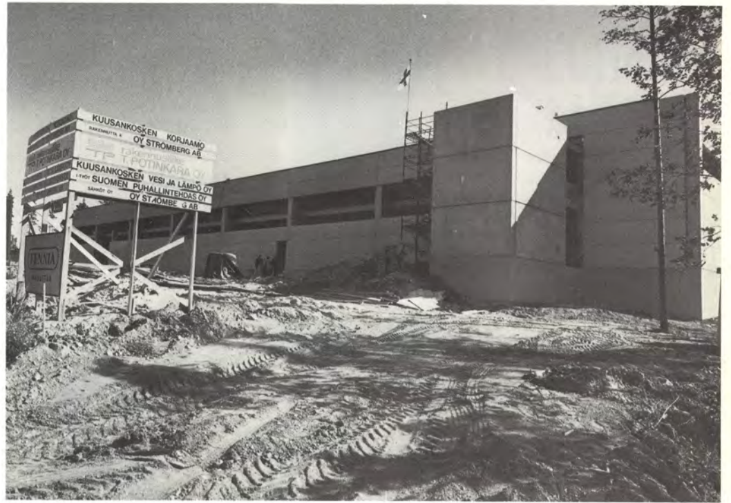
Strömbergin aluekorjaamo nousi harjakorkeuteen Katajajarjun teollisuusalueella Kuusankoskella syyskuussa. Rakennuksen pääura-koitsijana on rakennusliike T. Potinkara.
