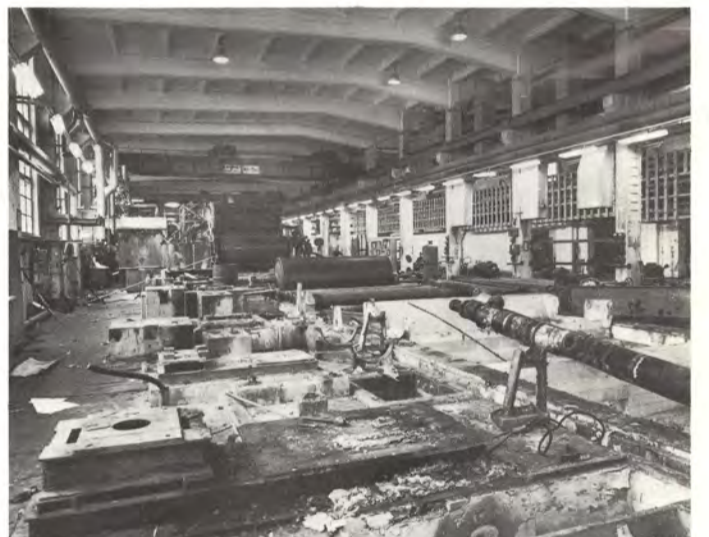
Purkutyöt olivat syyskuun alkupäivinä ennättäneet noin puoleen väliin konetta.
