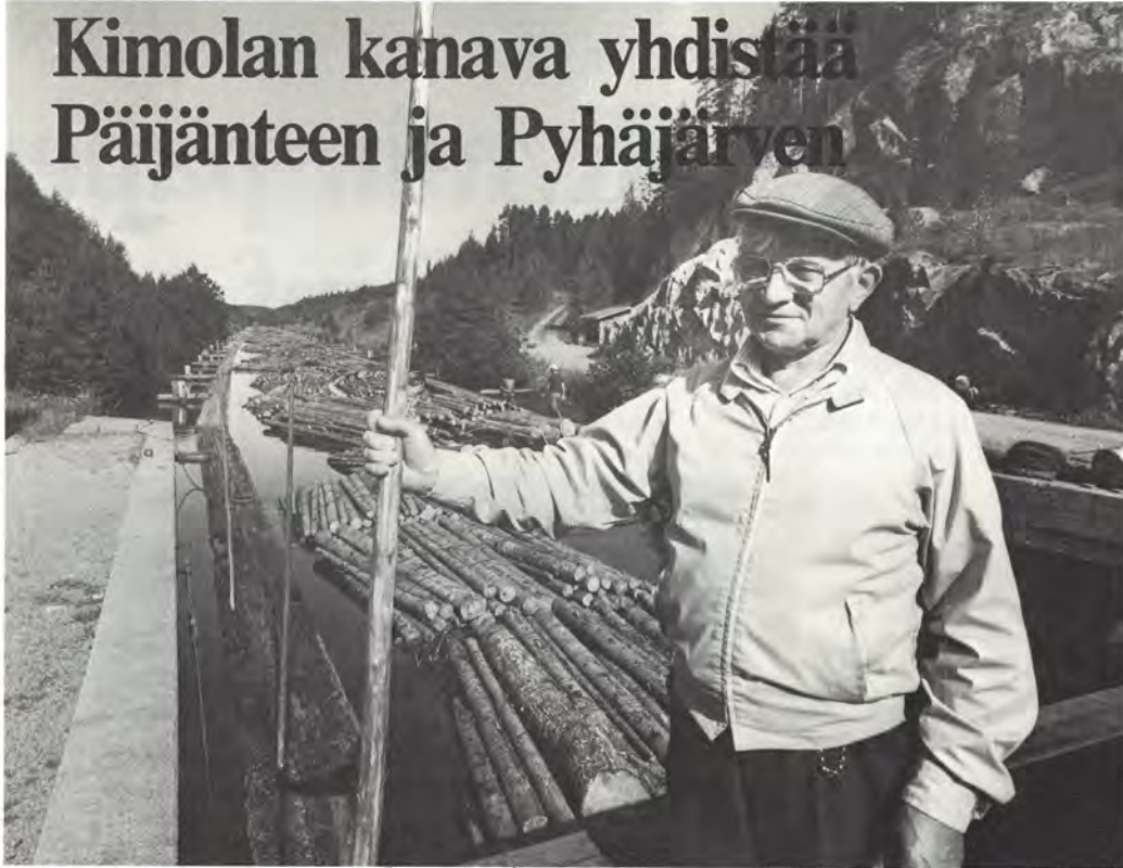
Työnjohtaja Esa Hyvösen takana Kimolan kanavan yläpuoli, josta tukkiniput lasketaan nosturilla alakanavaan.
