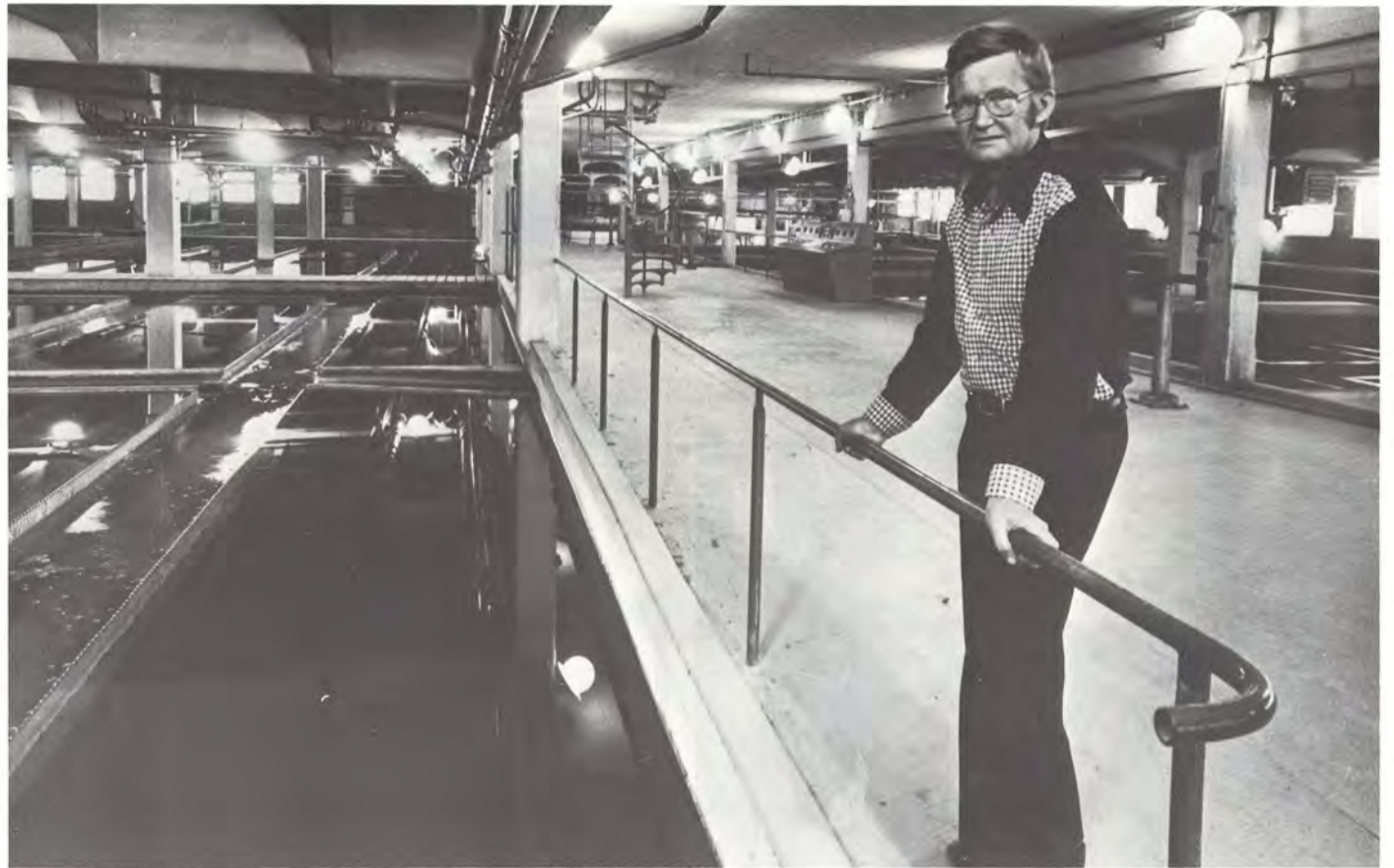
Sekä Kuusankosken tehtailla käytettävä juomavesi että prosesseissa tarvittava vesi puhdistetaan tutkimusosaston rakennuksen alakerrassa olevilla laitteilla. Laitosta esittelemässä Erkki Nyman.
