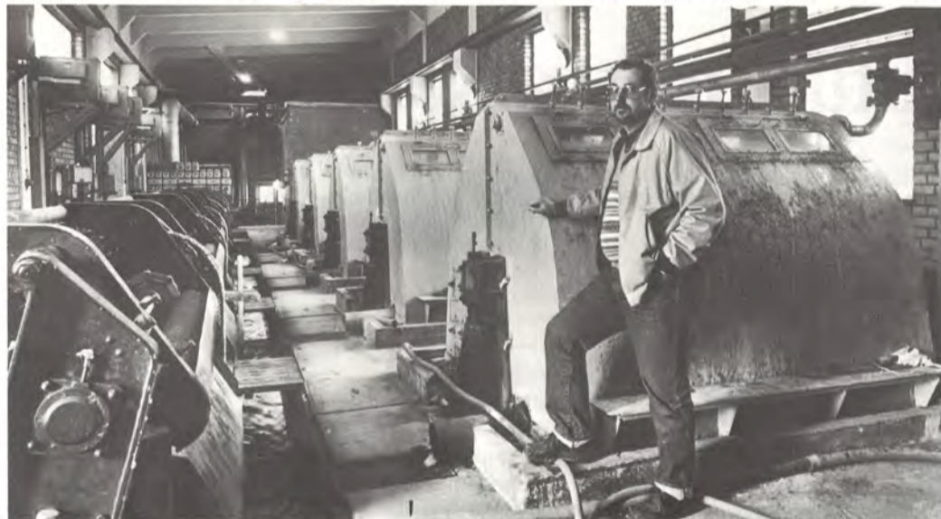
Käyttöinsinööri Timo Alarodun takana puhdistuslaitoksen hienosihti, vasemmalla sihdit, joihin raakavesi Kymijoesta ohjautuu.
