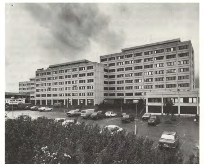
Santasalolaiset työskentelevät tämän vakuutusyhtiö Kalevan omistaman talon kuudennessa kerroksessa kuluvan vuoden loppuun saakka.
