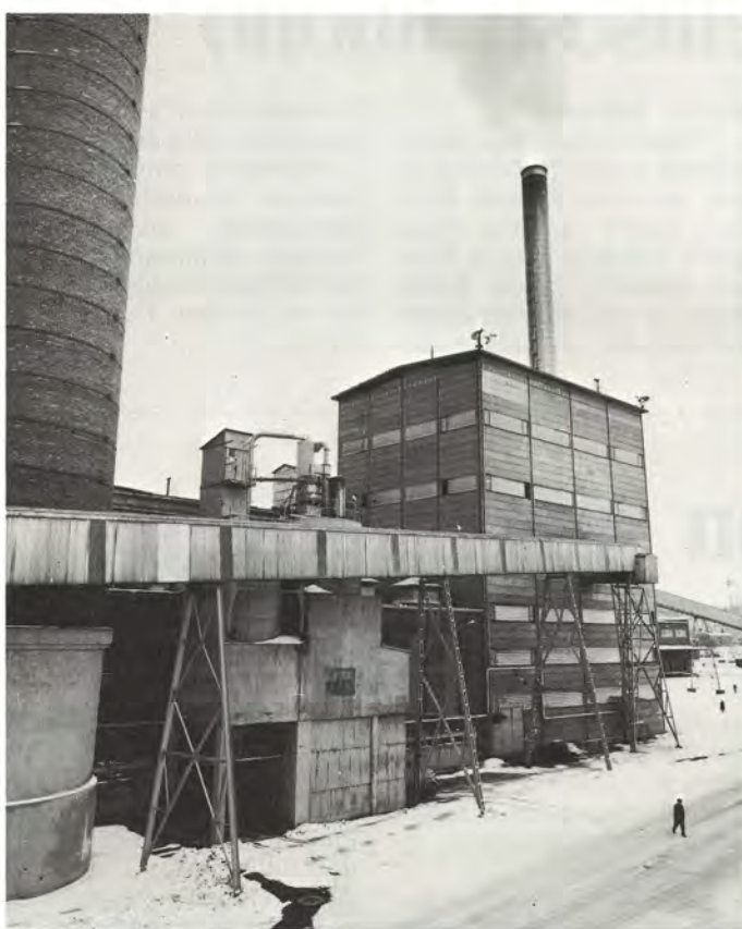
Kymin voimalaitosten kattiloissa pystytään käyttämään monia polttoaineita. Kuvassa Voikkaan höyryvoimalaitos, jossa voidaan polttaa kivihiiltä, öljyä, maakaasua ja puujätettä.
