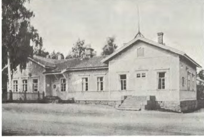
Kymintehtaan kansakoulun ensimmäinen rakennus sijaitsi ns. klubin portin tuntumassa Kymintehtaalla. Kun koulu siirtyi 1920-luvun alussa muihin tiloihin, taloon sijoitettiin huolto-konttori, palkkakeskus ja työnhakutoimisto. Myöhemmin vanha koulutalo palveli vielä mestarikerhona ja tehdasruokalana. Rakennus purettiin vuonna 1966.
