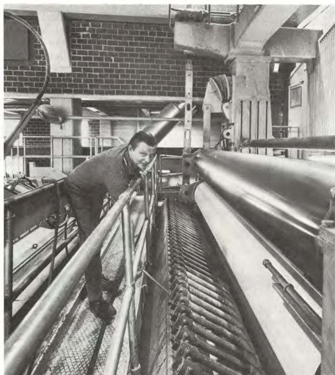
Silinterimies säättää kalanteritelan paksuutta laskemalla sille suuttimista kylmää paineilmaa.
