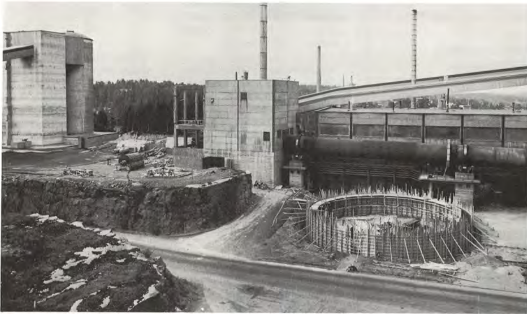
Meesakentän tilavuudeksi tulee noin 1600 neliometriä. Kentän yhteyteen rakennetaan tilat meesan kuivatussuotimelle ja liettimelle.
