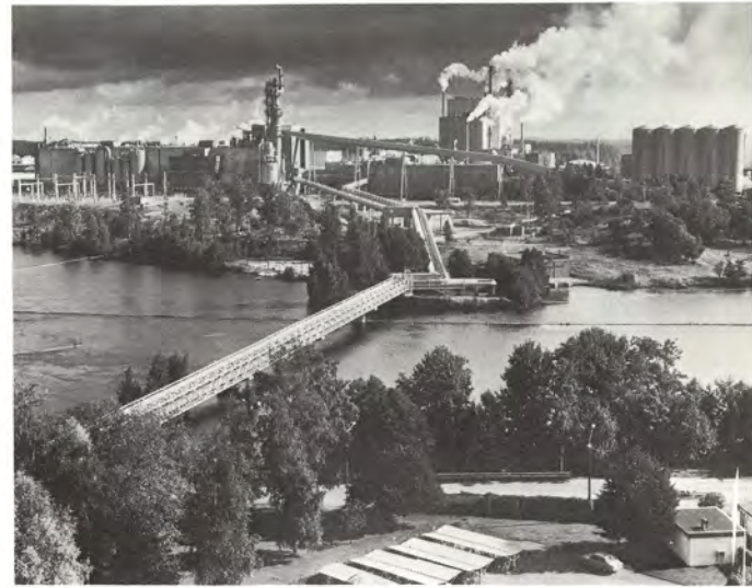
... mutta uusi soodakattila rakennettiin vanhan soodakattilan taakse. Putkisilta tukevoitui 1980-luvun alussa.
