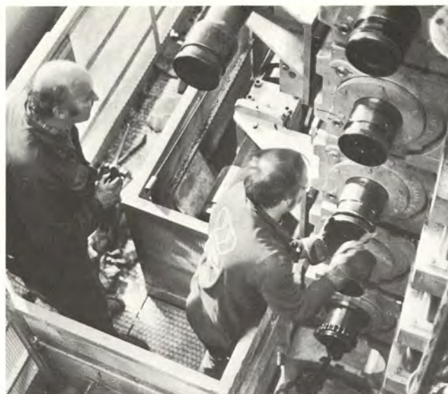
Superkalanterin höyrykytkimiä asennetaan paikalleen (vas.) ja uusintaa viimeistellään (oik.).
