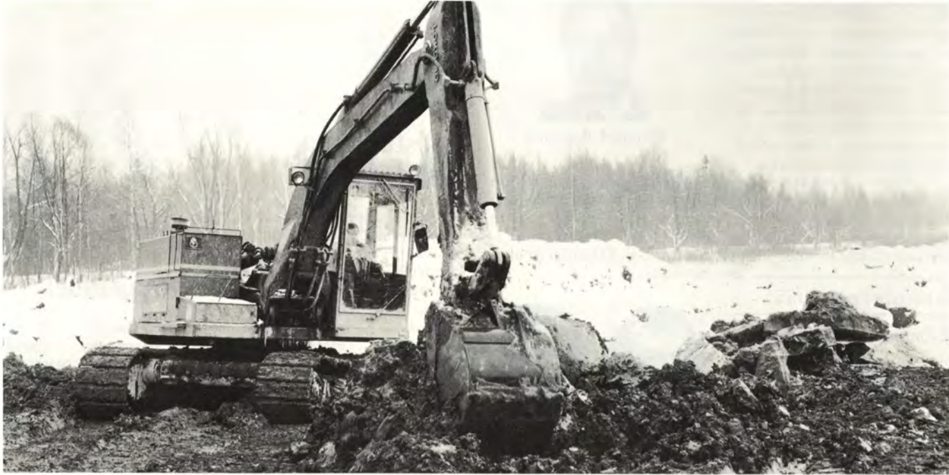
Saksanahon kaatopaikan maisemointiin liittyvän maavallin rakennustyöt ovat parhaillaan käynnissä. Vallin Ahlmannintien suuntaisen osan pituudeksi tulee alkuvaiheessa noin 70 metriä.
