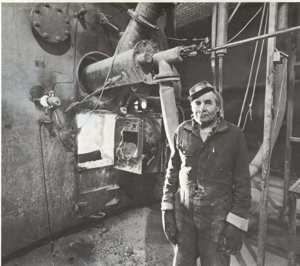
Valkoliipeämön hoitaja tarkastaa kierroksellaan, että paikat ovat kunnossa. Pentti Taavilan takana näkyy meesauunin pää.
