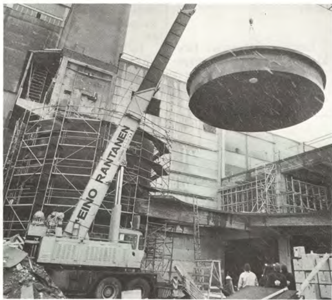
Pesulipeäsäiliön kansi nostettiin paikalleen maaliskuun lopussa. Myös muissa työvaiheissa käytettiin runsaasti nostureita.
