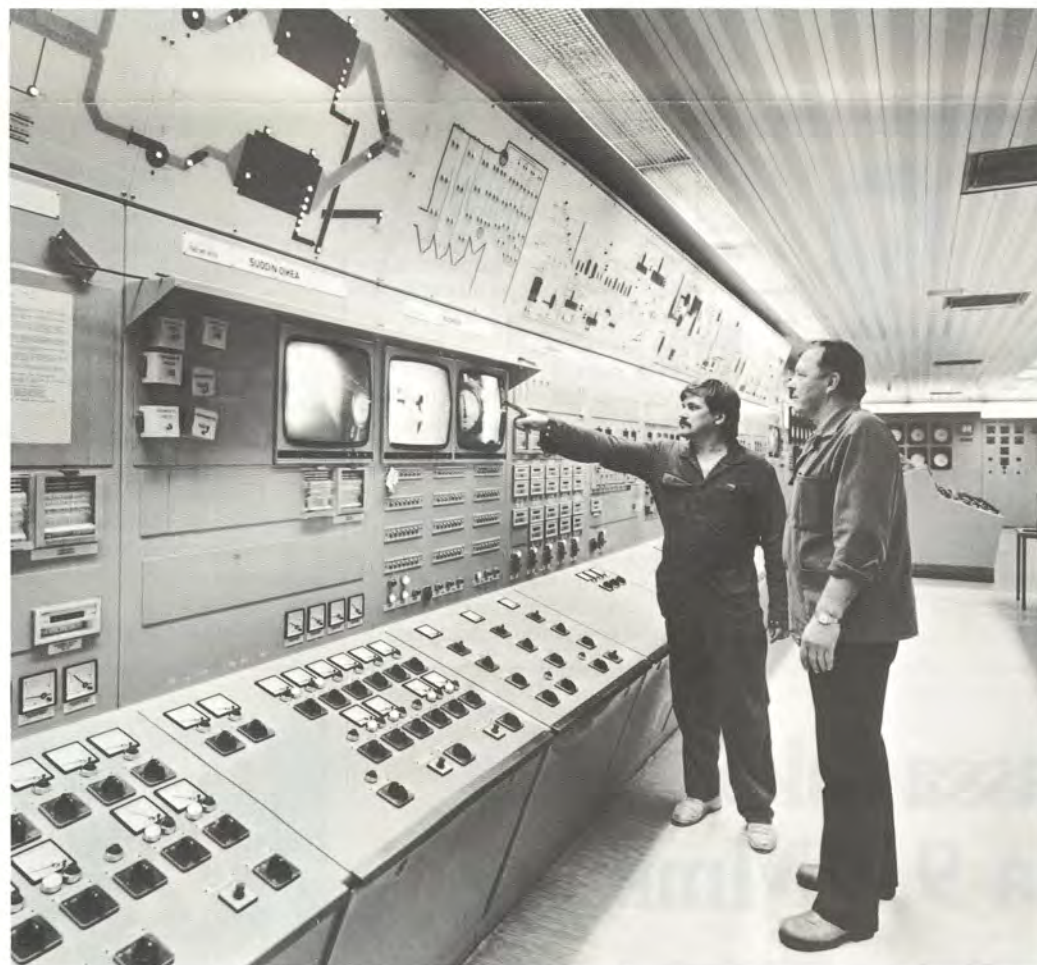
Markku Kansikas (vas) ja Markku Ahola tutkivat 2-soodakattilan vesipintaa vesilasista, joka näkyy valvomoon monitorista.
