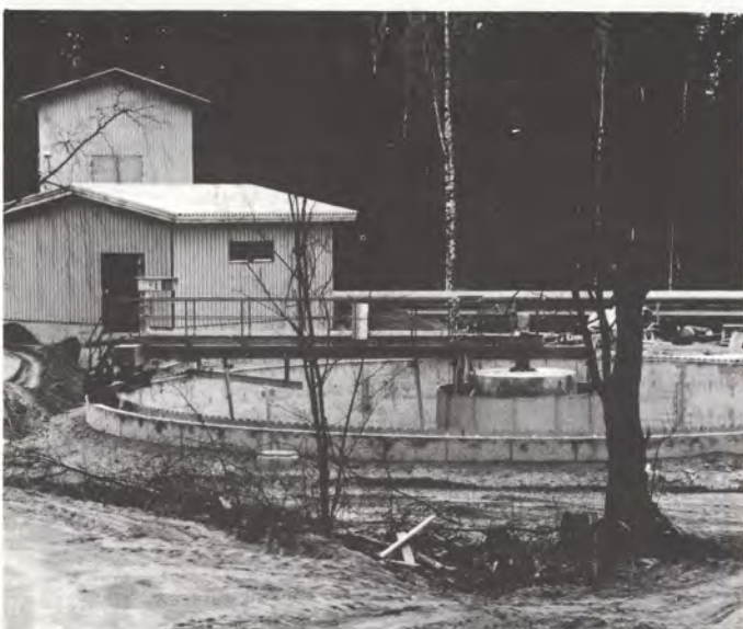
Juantehtaan uuden jätevesilaitoksen esiselkeytinosan vieressä sijaitsee kemikalointi- ja pumppaushuone. Taustalla olevassa rakennuksessa tapahtuu kiintoaineen erotus suotonauhapuristimella.
