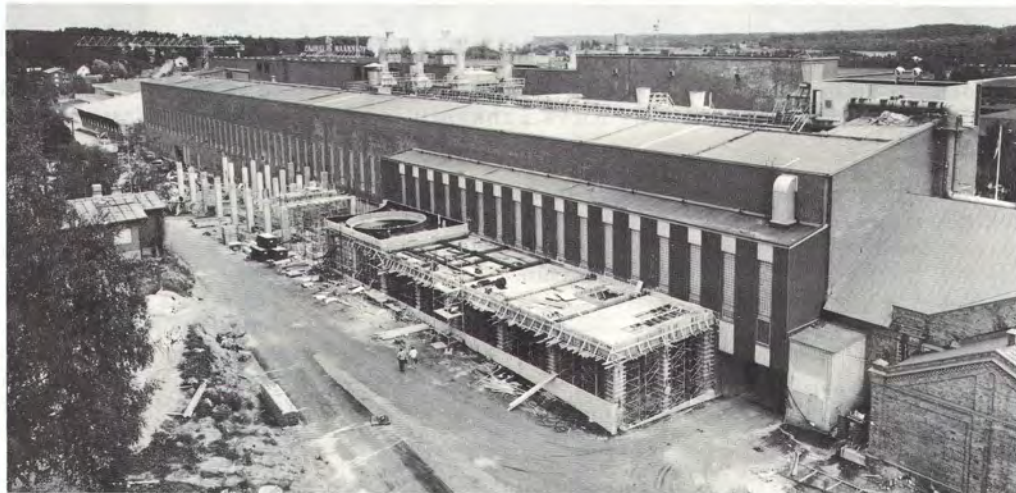
Tehtaan pohjoispuolella, PK 11:n konehallin viereen nousevat pastakeittämö- (etualalla) ja kiekkosuodinrakennukset.
