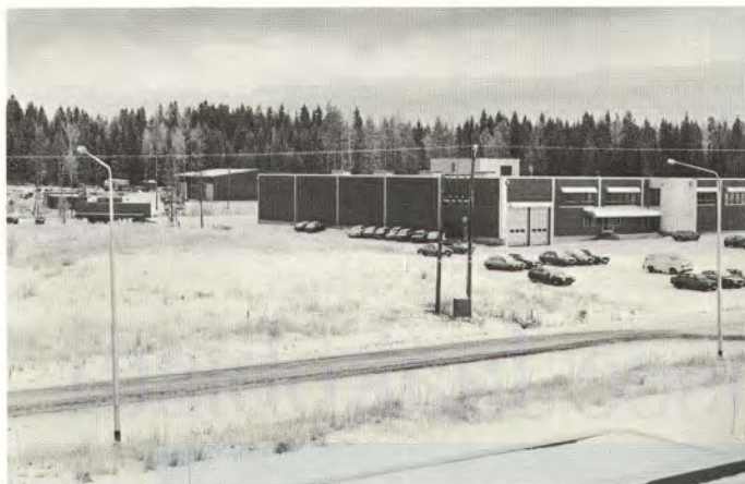
Uusi halli sijoittuu kirjapainorakennuksen vasemmalle puolelle.
