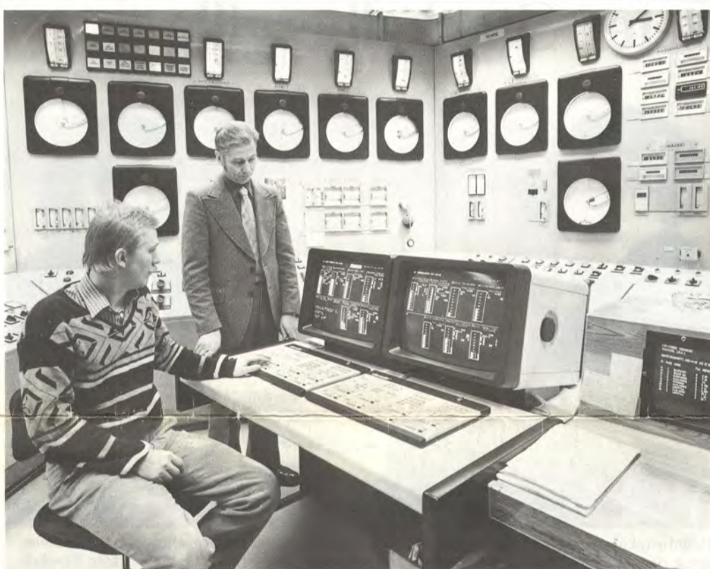
Esilajittamon prosessinohjaus hoidetaan Damatic-prosessinohjausjärjestelmällä vanhan valkaimon ohjaamosta. 2-keittäjä Esa Koivula (vas.) ja kehityspäällikkö Anssi Vesanen käynnistävät sakeamassatornin sekoitinta.
