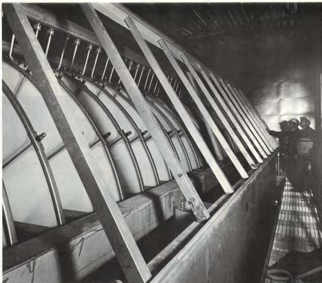
Voikkaan PK 11:n kiekkosuotimen kiekkosegmentit kuvattuna asennustöiden aikana.
