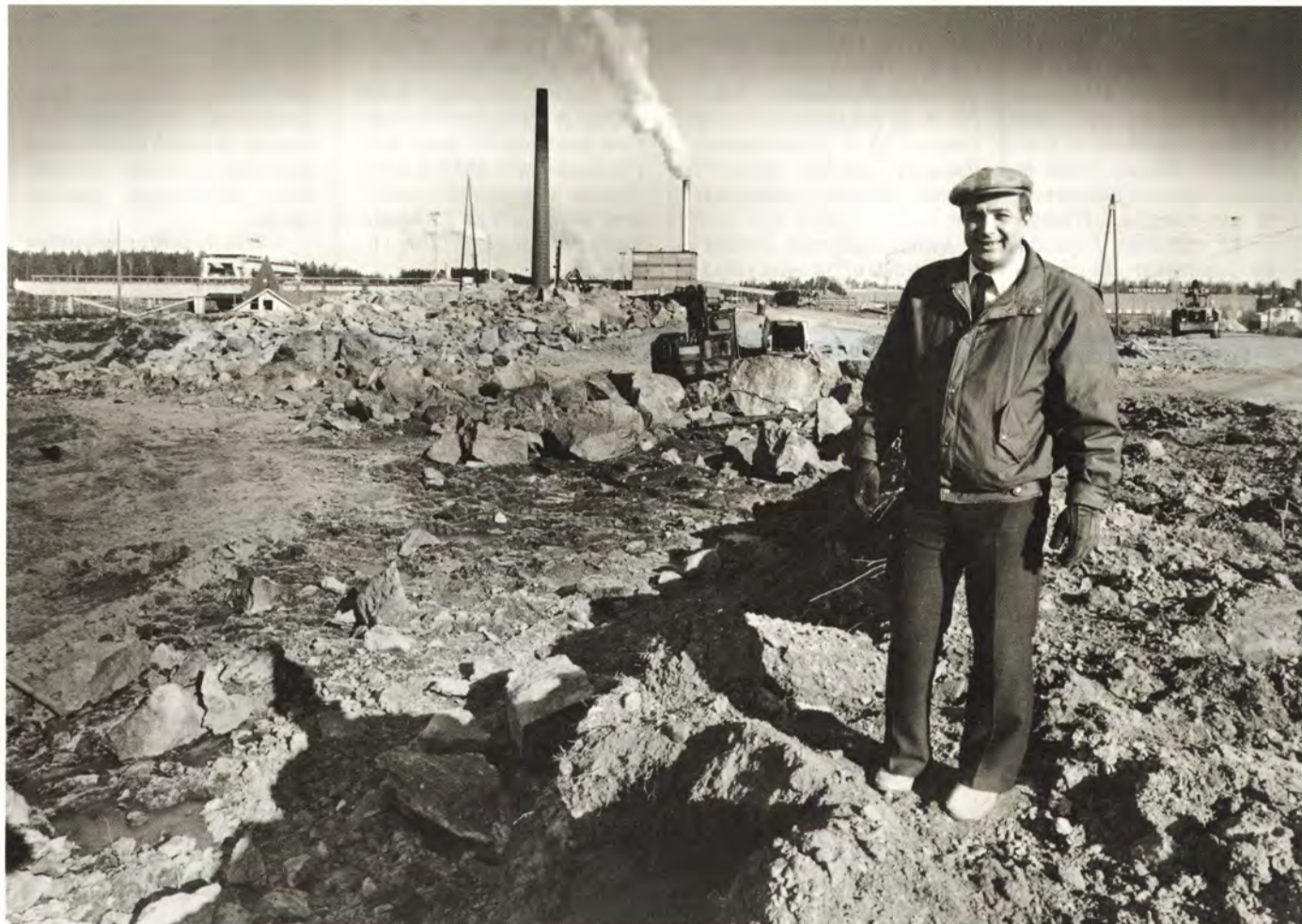
Rakennusosaston päällikkö Markku Pasi esittelee Voikkaan puukentän laajennusosaston työmaata. 3,5 hehtaarin suuruinen laajennus sijaitsee nykyisen puukentän eteläpuolella.
