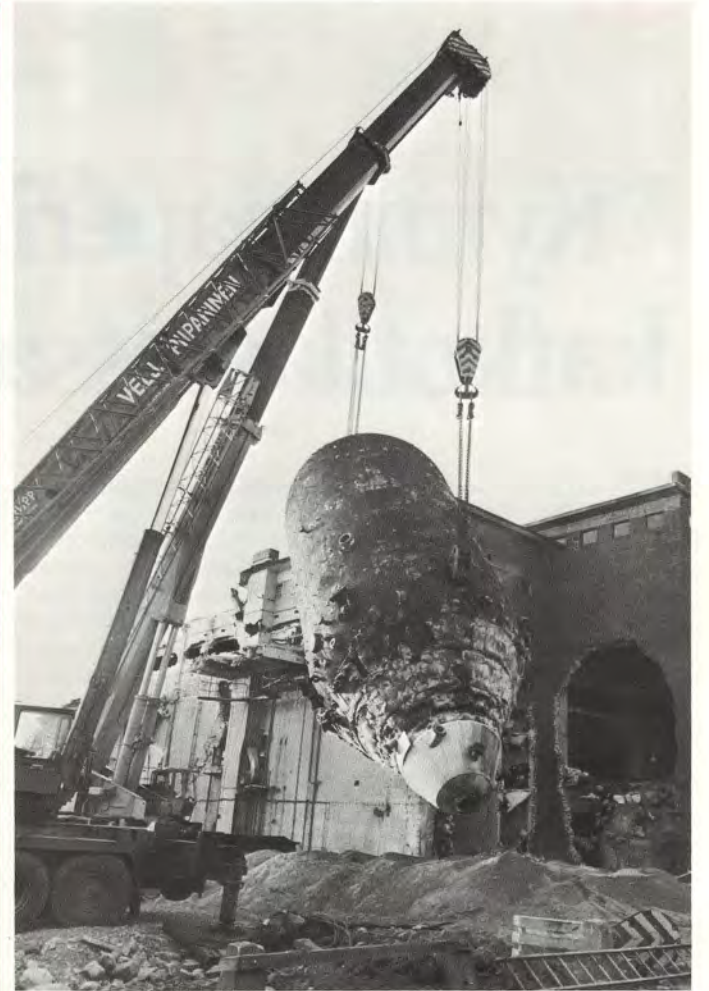
300 kuution suuruinen keitin nostettiin kahden nosturin avulla hiekkapetille.
