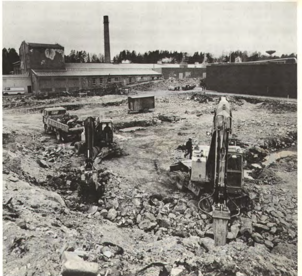
Uudet tilat rakennetaan nykyisen jälkikäsitteilyosaston jatkoksi ja kartonkikoneen suuntaiseksi. Keväällä alueella louhittiin laajalti kalliota.
