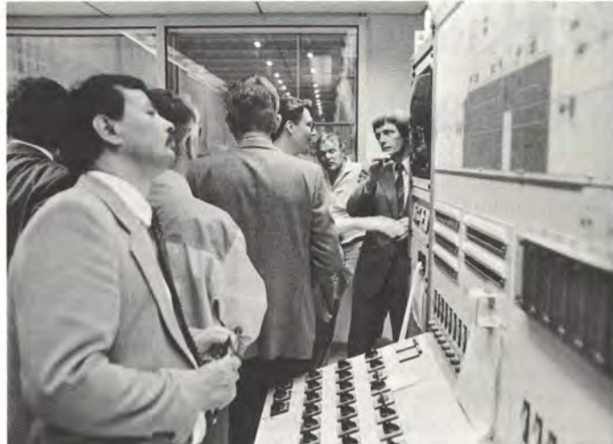
Saksalaisvieraiden kiinnostuksen kohteena olivat erityisesti automaatio- ja valvomoita. Kuva PK 8:n kuivanpään valvomoista.
