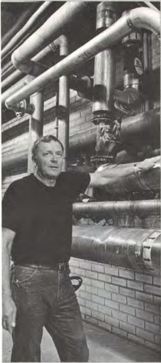
Haihduuttamon pesuongelmat hävisivät, kun haihduuttamon hoitaja Markku Ahola keksi ratkaisun uuden pesuputken (yllä) asentamiseksi.
