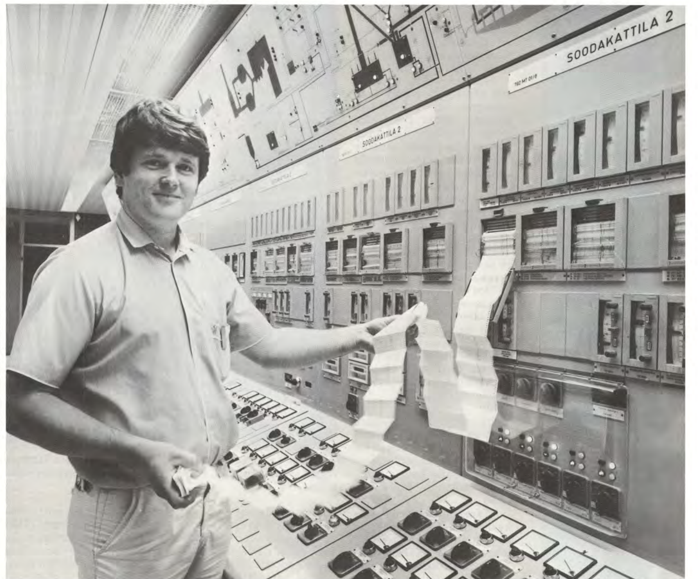
Soodakattilalaitoksen ohjaamossa näkyy ensimmäinen elon liekki, kun sellutehdasta käynnistetään. Ylikonemestari Raine Rantasen kädessä kattila 2:n höyrykehitystä kuvaava piirturipaperi.
