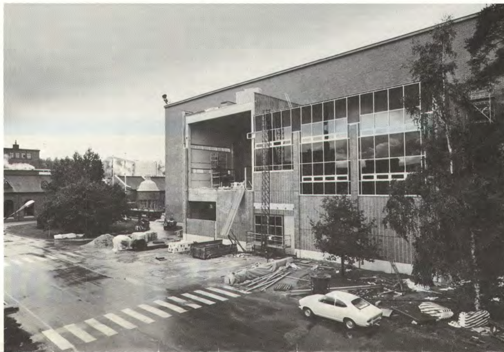
Ulospäin näkyvin muutos PK 18:n uusinnasta on konesalin länsipäätyyn rakennettava kiekko-suodinrakennus.
