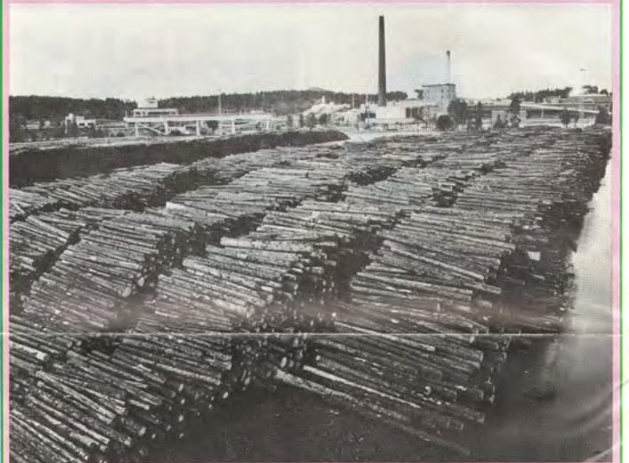
Puukentän laajennus nosti Voikkaan puuvaraston tilavuuden 25 000:sta kuutiometristä 60 000:een.
