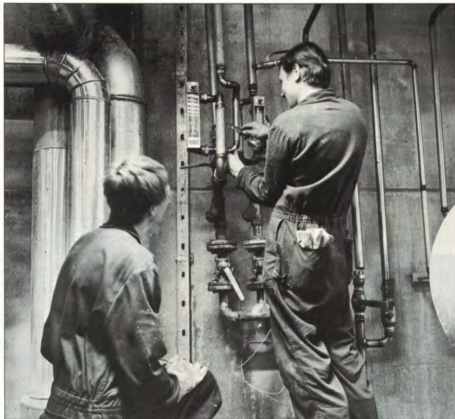
Timo Oksanen ja Tapio Hannola korjaavat retentioaineputkistoa paperikoneen alakerrassa.
