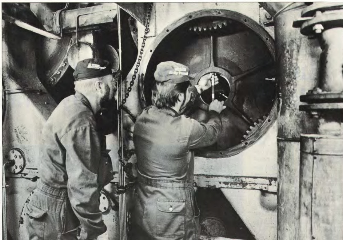
Arto Lepistö (vas.) ja Vesa Värrö mittaavat PK 7:n kuudennen kuivatusryhmän käyttöakselin laakeripesää, joka sorvattiin erikoiskalustolla.
