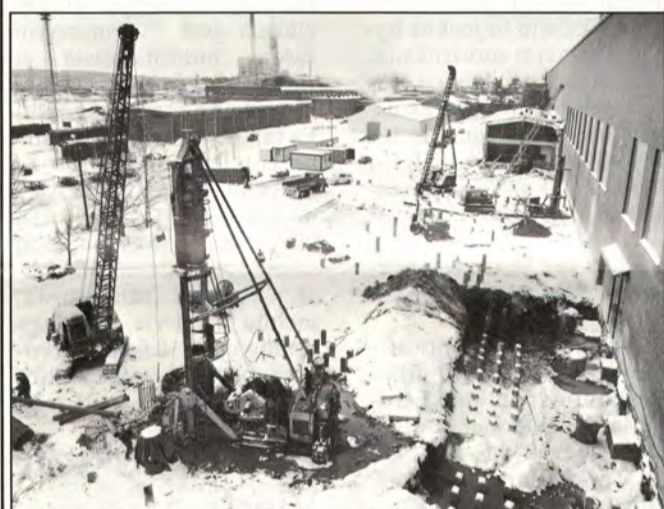
Uudisrakennus nousee konehallin eteläseinustalle.
