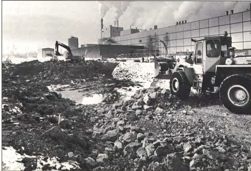
Työmaalla on aloitettu paperikonehallin rakentamiseen ja rautateiden siirtoon liittyvät maansiirto- ja louhintatyöt.
