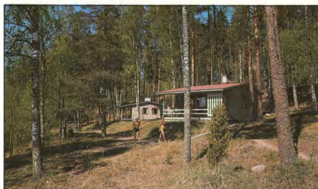
Lautarakenteisia lomamajoja on remontoitu sekä ulko- että sisäpuolelta.
