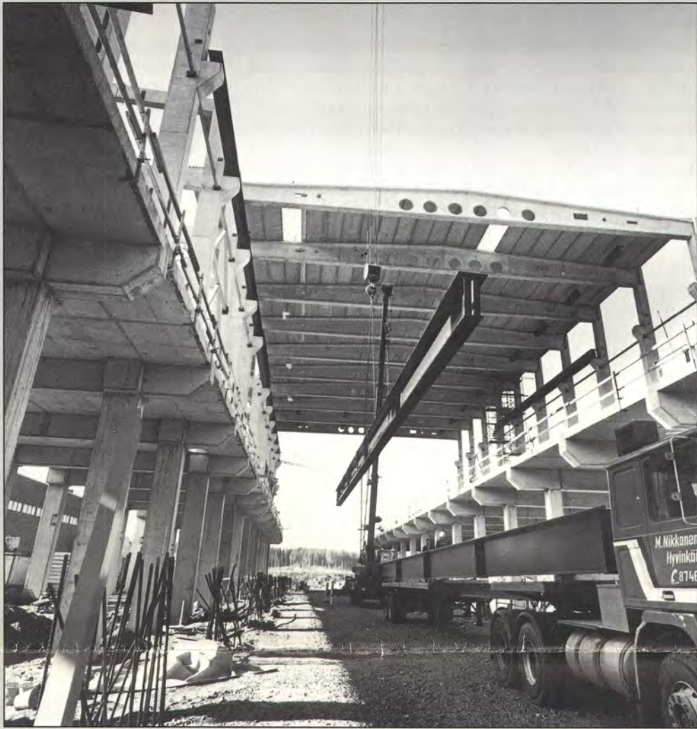
Elokuun viimeisellä viikolla PK 9:n rakennustyömaalla asennettiin paperikoneen nosturikiskoja.
