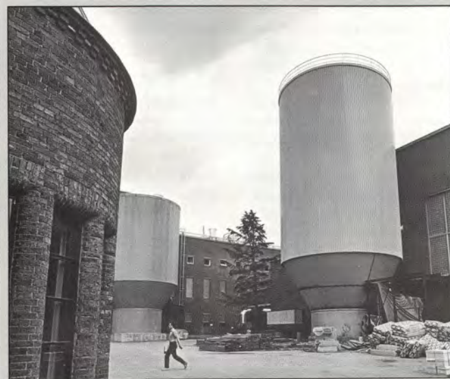
PK 18:n konosalin märkään päähän valmistunut torni (oik.) liittyy paperikoneen uusittuun kierto-vesijärjestelmään, joka otettiin käyttöön juhannuksen jälkeen. Uusinnan ansiosta paperikoneen ajettavuus on parantunut.
