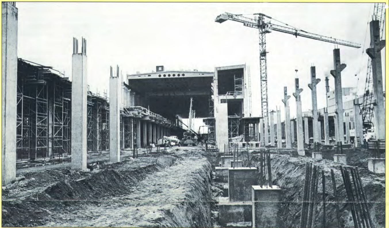
PK 9:n konehallin runko on valmis, kuten myös jälkikäsitteilyhallin perustukset. Arkkisalin laajennusosan perustuksia ryhdytään tekemään marraskuussa.
