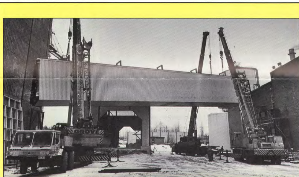
PK 8:n ja PK 9:n yhdistävä, 35 tonnin painoinen putkisilta nostettiin paikalleen marraskuun 21. päivänä.
