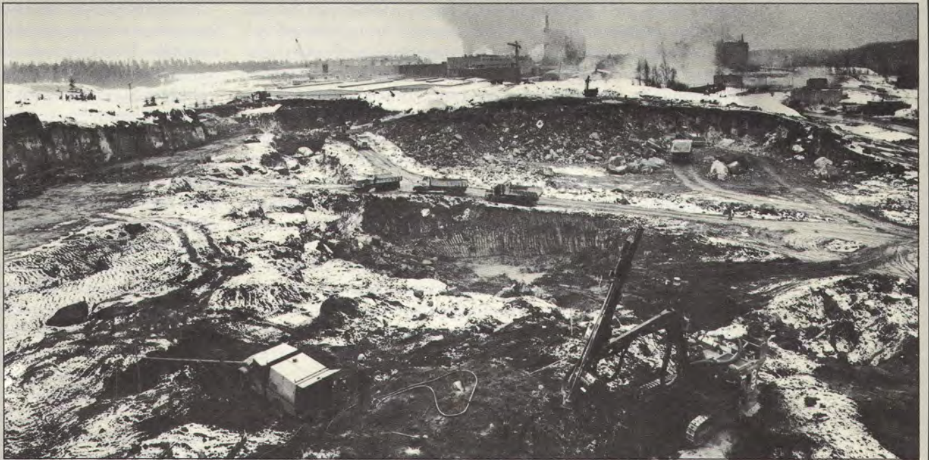
Puhdistamon tieltä louhitaan noin 340 000 kiintokuutiometriä kalliota.
