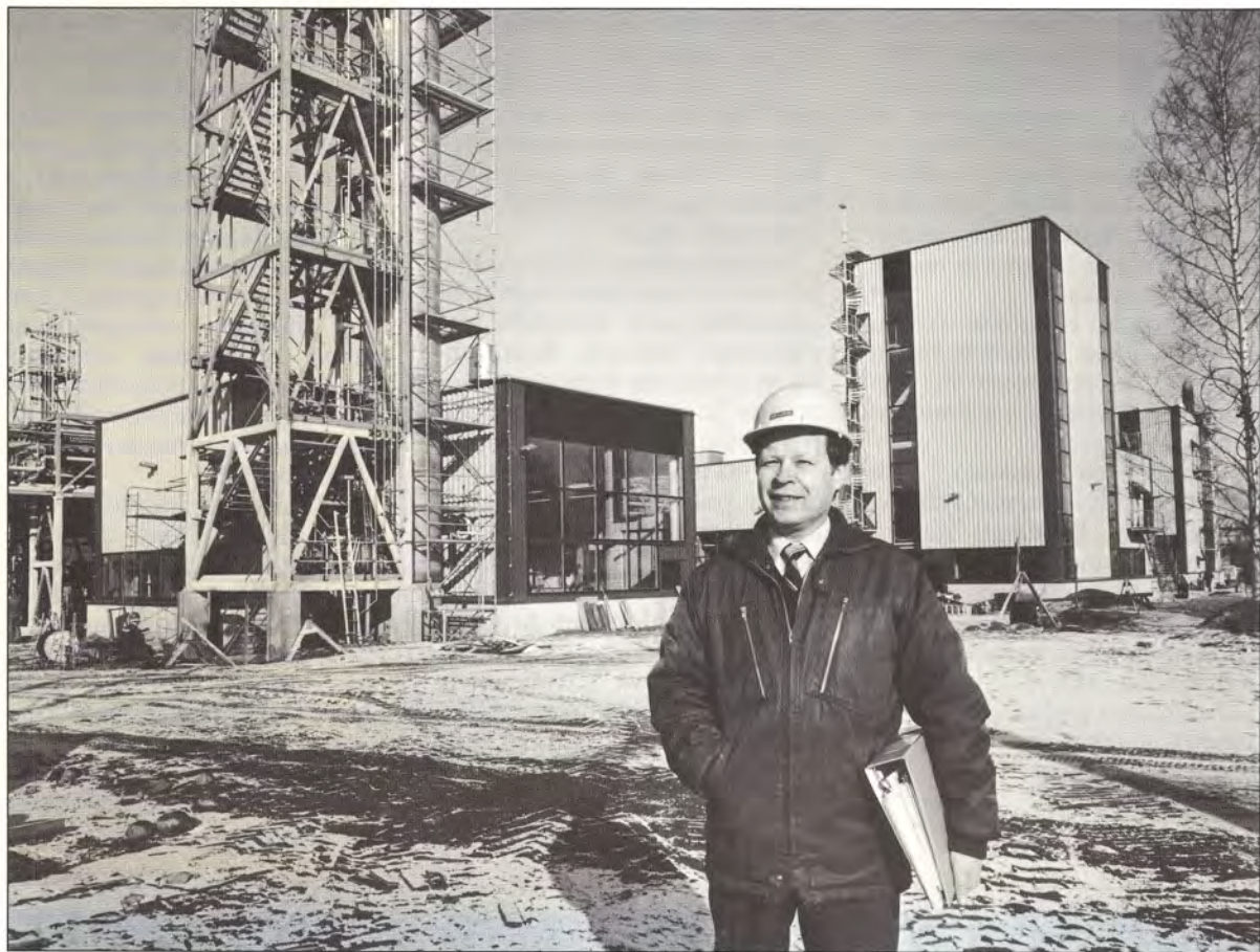
Käyttöpäällikkö Seppo Meriluoto taustallaan uusi peroksiditehdas, joka koostuu kolmesta osasta, vaiheet - pelkistys, hapetus ja uutto - on sijoitettu omiin rakennuksiinsa.
