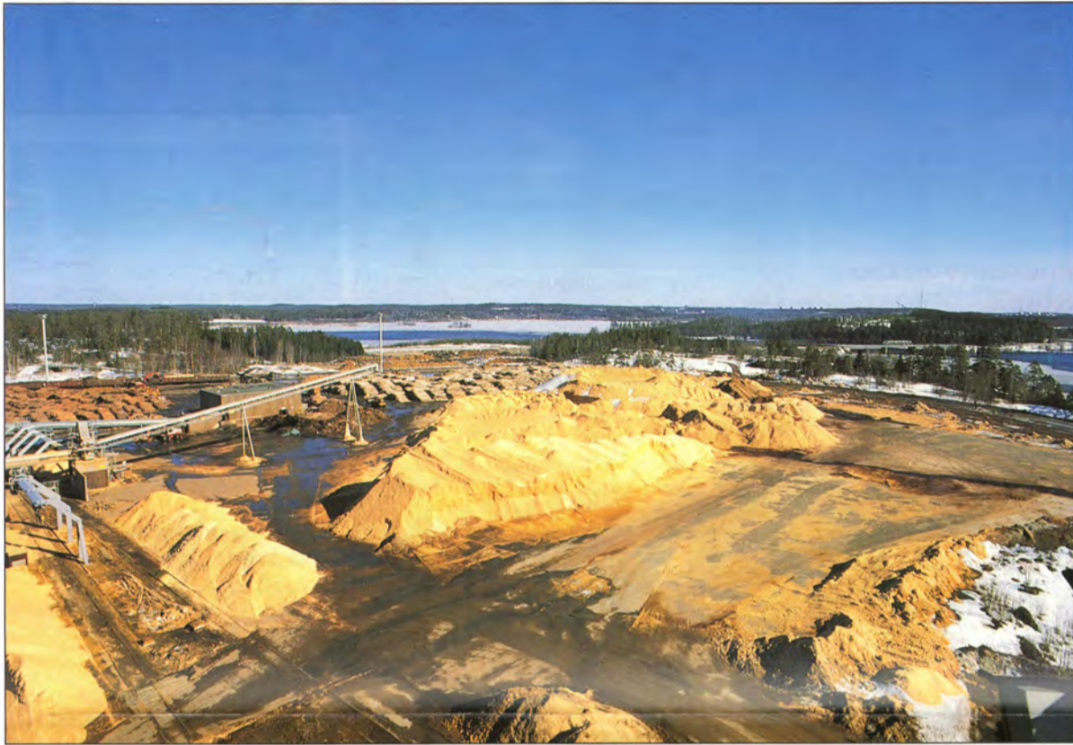
Kuusanniemen puunkentän näkymät muuttuvat huomattavasti käynnistymässä olevien rakennustöiden myötä. Vasemmalle nousee uusi kuorimo, oikealle sijoittuvat uudentyyppiset hakekasat ja kohteiden välille tulee kuljettimia. Puunmittauspaikka siirtyy nykyiseltä paikaltaan lähemmäs Kuusanniemen porttia.
