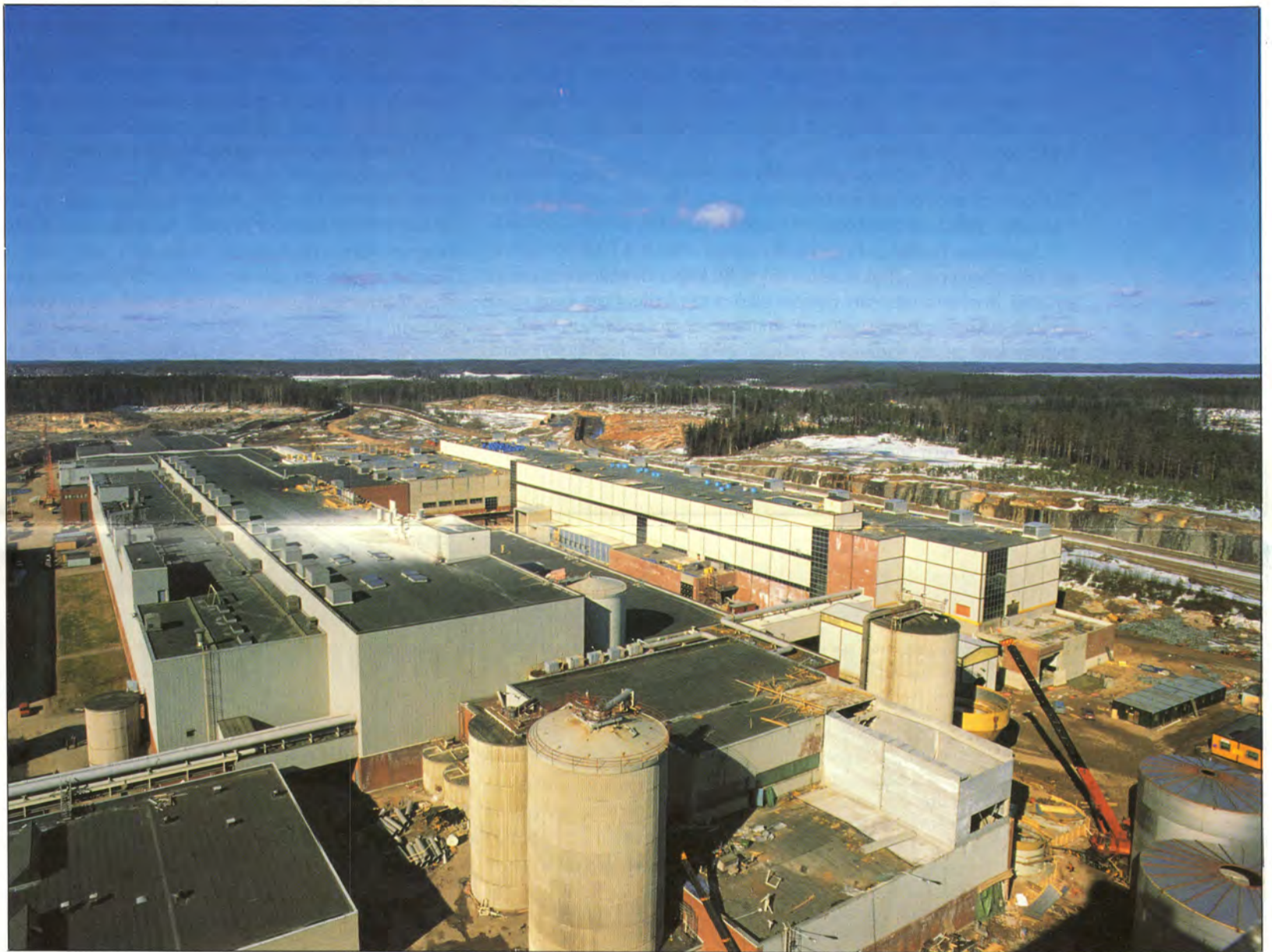
PK: 9:n konehalli kuvassa keskellä, vasemmalla PK 7:n ja PK 8:n rakennukset. Alhaalla oikealla valmistumisvaiheessa olevia massatorneja.
