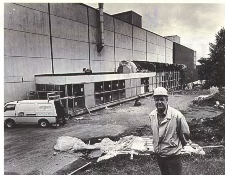
Projekti-insinööri Paavo Floman vetää päällystyslaitoksen uudistusprojektia. Hankkeeseen liittyy rakennustöitä mm. valvomo-osan moleminpuolin.
