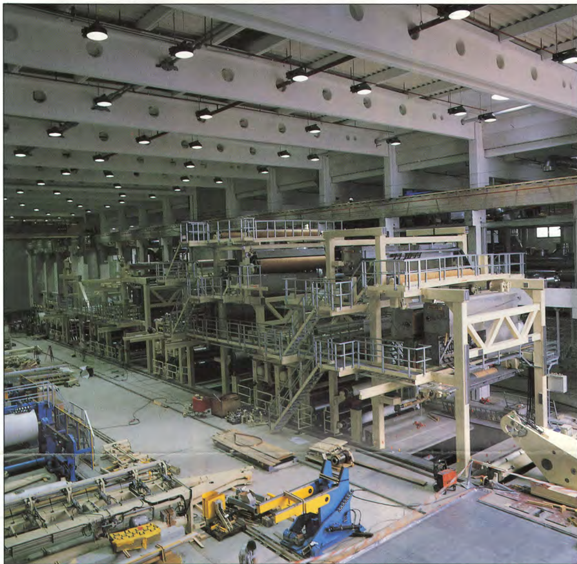
Nordland Paperin päällystyslaitoksen asennustyöt ovat loppusuoralla.
