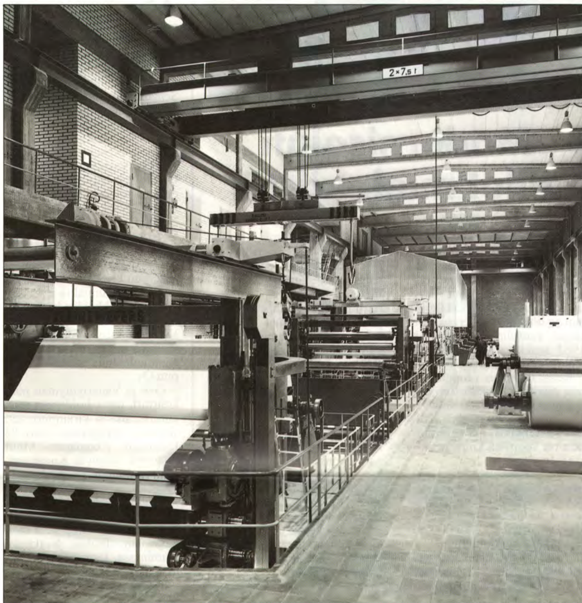
Vuonna 1968 käynnistynyt päällystyskone 1 (yllä) toi Kuusankoskelle teräpäällystyskoneen. Kone valmistaa viimeiset paperitonninsa lokakuun lopussa.
