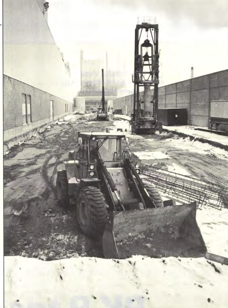
Rakennustyöt ovat alkaneet PK 7:n konesalin vieressä.
