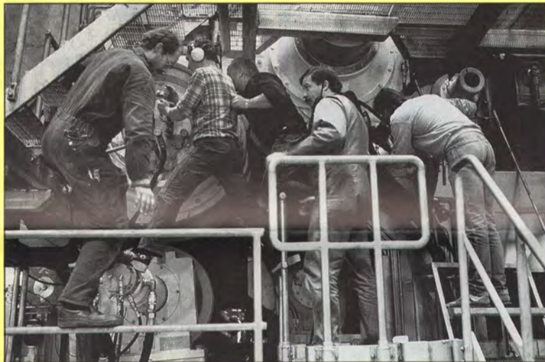
Paperikoneen käyntiinajamisessa tarvitaan konemiestien ja asennusväen tiivistä yhteistyötä. Kuva koneen puristinosalta.
