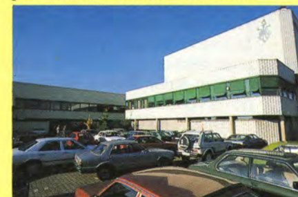
Freytag & Petersenin varastojen kautta kulkee yli sata tonnia paperia päivittäin.
