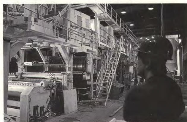
Päällystyskone 2 käynnistyy helmikuussa.
