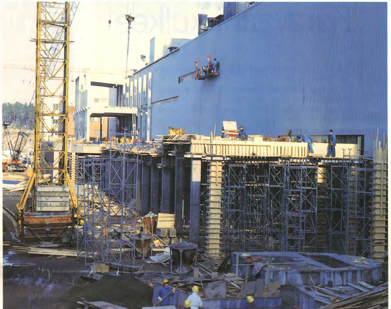
PK 7:n uusinnassa ovat parhaillaan menossa lisärakennuksen elementtiasennukset.
