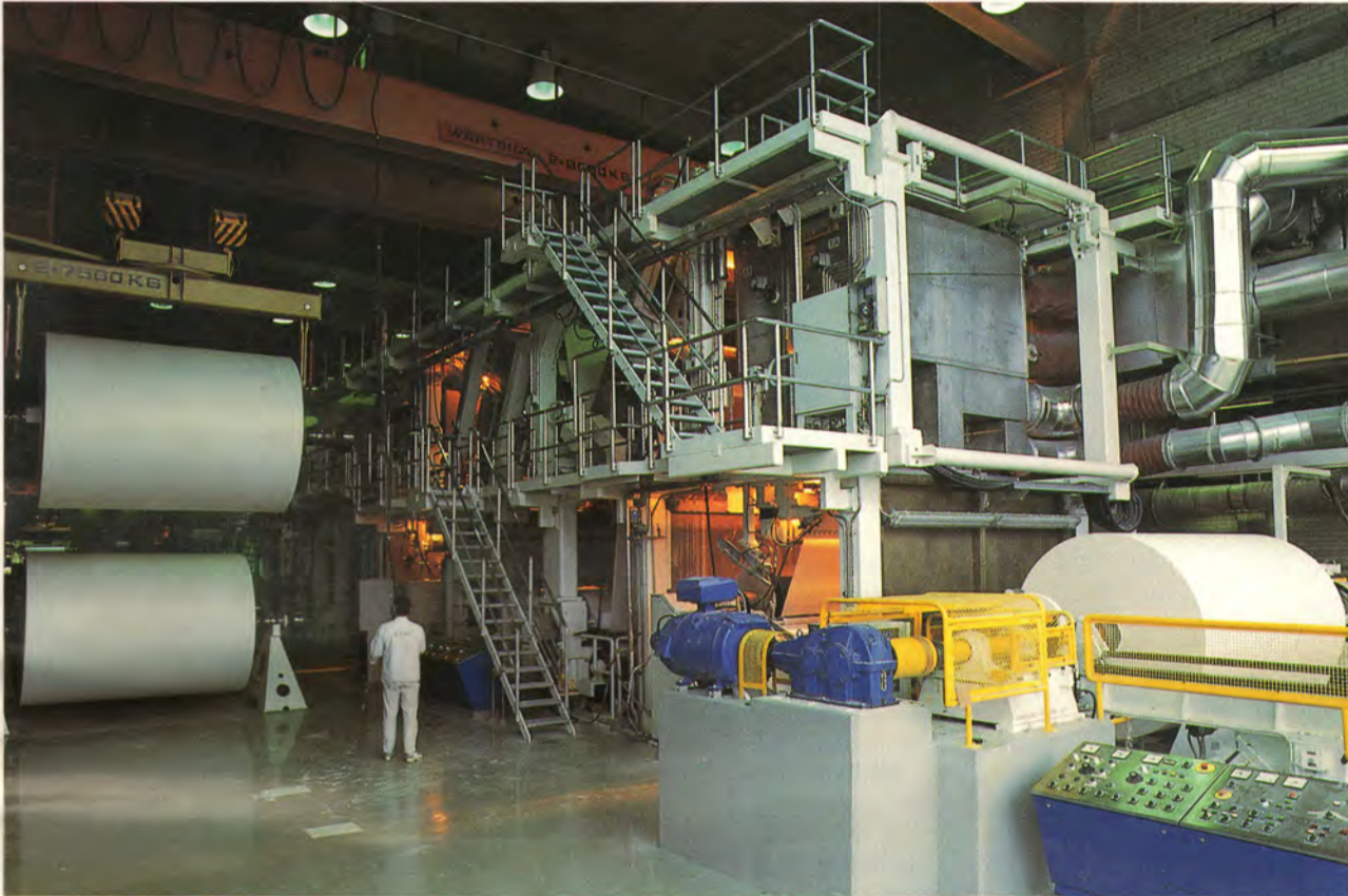
Kymin uusittu päällystyskone pystyy tuottamaan noin 90 000 tonnia kaksoispäällystettyä paperia vuodessa. Tämä Uutiskymi on painettu uudelle, kaksoispäällystetylle KymexCotelle, jonka pintapaino on 115 g/m 2 .
