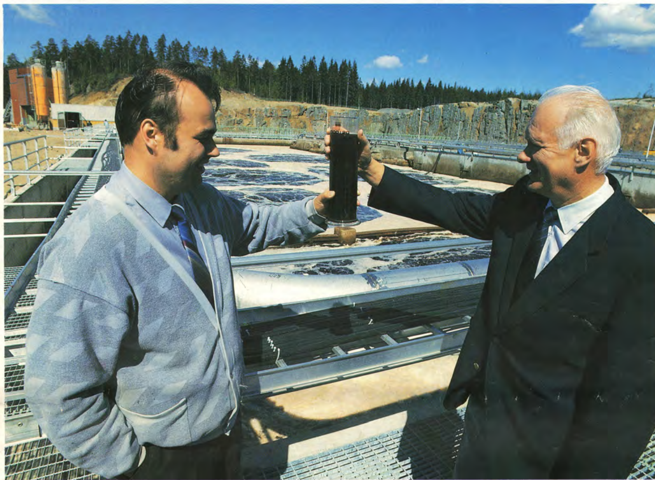
Biologisen puhdistamon bakteeriston kehittyminen täyteen toimintakuntoon kestää kahdesta neljään viikkoon. "Biolietteen kasvu on edistynyt suunnitelmien mukaisesti", tuumivat tehdastutkimusinsinööri Harri Jussila ja paikallisjohtaja Ilmari Lindberg tyytyväisinä.
