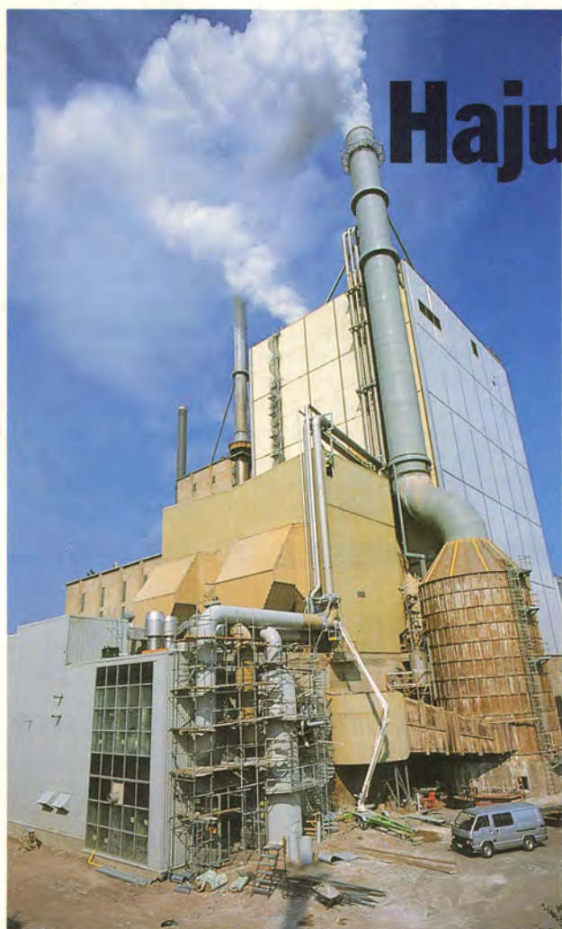
Hajukaasukattila (vas.) on sijoitettu 2-soodakattilan eteläpuolelle.
