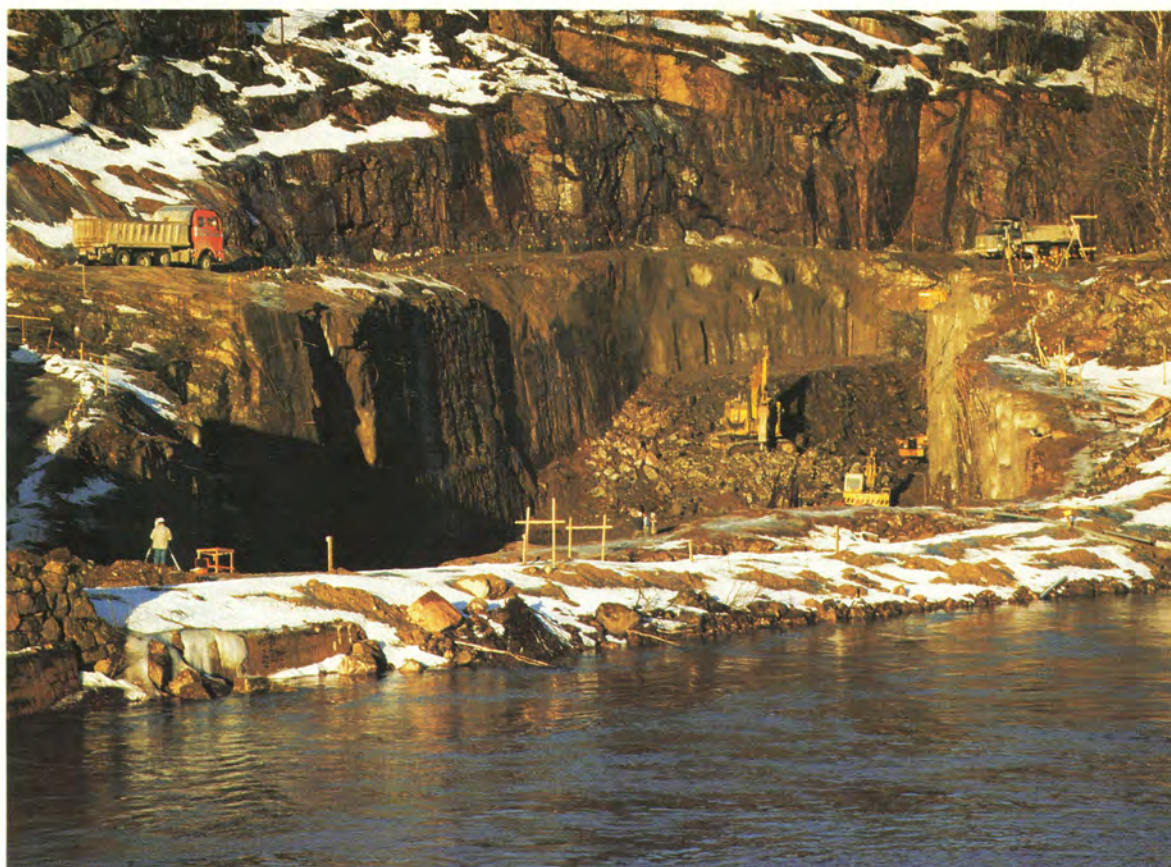
Voimalaitoksen alapuolinen kanava on louhittu valmiiksi lukuun ottamatta työpatoa, joka erottaa kanavan joesta.
