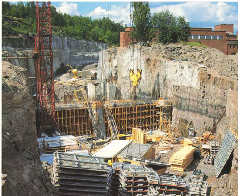
Heinäkuun ajan voimalaitostyömaalla työskennellään yhdessä vuorossa.
