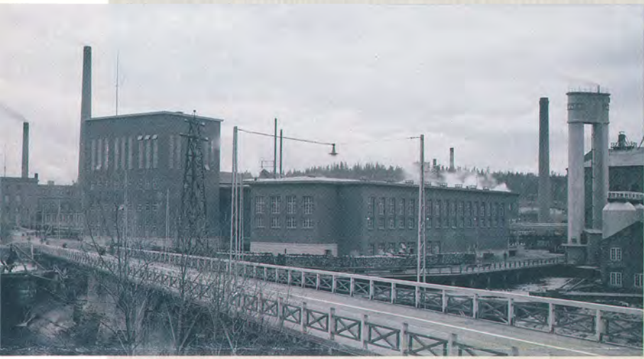
Nykyinen klooritehdas viimeisen laajennuksen jälkeen (1936).
