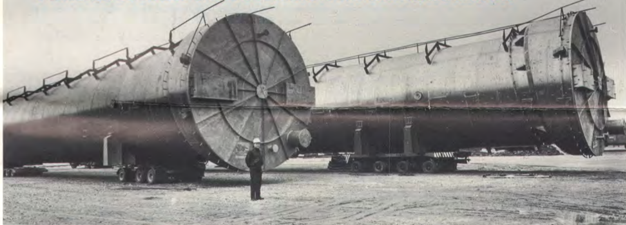
L4-linjalle marraskuussa asennettavat 41-metriset, halkaisijaltaan kuusimetriset titaaniset valkaisutornit siirrettiin 16.10. vastaisena yönä Lovilsasta Kuusanniemeen. Petroskoissa valmistettujen tornien edessä "mittakaavana" asennuspäällikkö Vilho Pihlgren.
