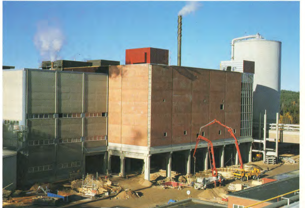
Uuden valkaisu linjan laiteasennukset alkavat lokakuun lopulla. Parhailaan rakennuksessa tehdään pintalattioita sekä sähkötiloja. Myös valkaisu torien perustusten teko on alkanut.
