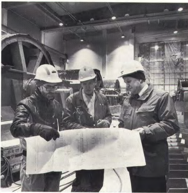
4-linjan päälaitteet on asennettu. Asennusvalvoja Kari Huovila (vas.), Sunds Porin tehtaan työnjohtaja Jorma Teeräs ja asennuspäällikkö Paavo Floman tutkivat piirustuksia.
